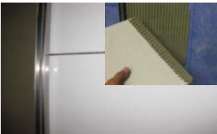
**4** Fliesen im Dünnbettverfahren ansetzen. Darauf achten, dass die Fliese im Schenkelbereich ausreichend mit Kleber benetzt ist.
