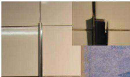
**5** Fliesen auf der Innenseite des Profils unter die Aufnahmeschale einschieben. Somit wird ermöglicht, dass bei raumhoher Befliesung der Fugenschnitt über dem Profil beibehalten werden kann.
