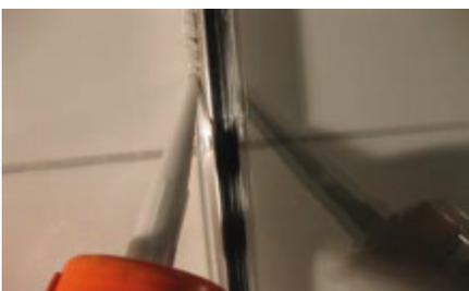
**7** Die Fuge zum Profil beidseitig mit neutralvernetzendem Silikon schließen. Das Profil und die Fliese muss hierzu trocken und fettfrei sein.
