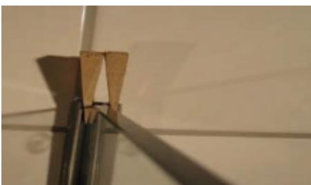
**8** Glasscheibe in Profil einstellen und ausrichten. Ein direkter Kontakt zwischen Glas und Edelstahl darf nicht erfolgen. Die seitlichen Flanken zwischen Glas und Profil mit transparentem Dicht- und Montageklebstoff füllen.
