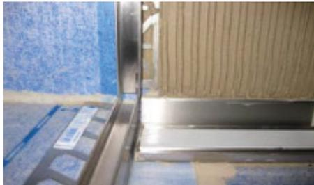
**2** Das Wandprofil ist vom waagrechten, abgedichteten Boden aus 19,8 mm höher anzusetzen. Höhe mit dem AQUA-KEIL Glas überprüfen, bevor sich das Wandprofil nicht mehr korrigieren lässt.
